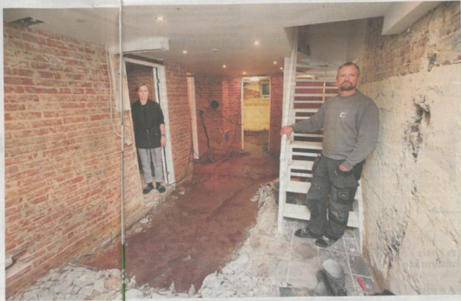
Indtil udsaltningsgen af kloakene på Nørholmvej, havde Charlotte Føjbjerg og Dennis Jensen en tør kælder. Efter kloakudskiftningen steg området grundvand og oversvømmelse kælderen i parrets hus. Tilsvarende problemer ventes ved den igangværende kloakudskiftning i Sunds, men her får husjerne mulighed for at købe sig til ekstra dræning i de offentlige kloaker, hvis vandet nu sænkes
